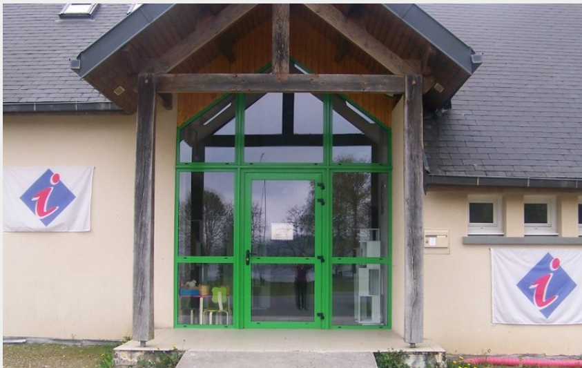
Crédit photo : Extérieur OT_1 (OT Lac de Vassivière)
