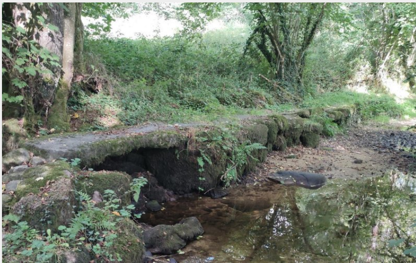
Pont planche et passage à guet (Mairie de St Martial le Mont)
