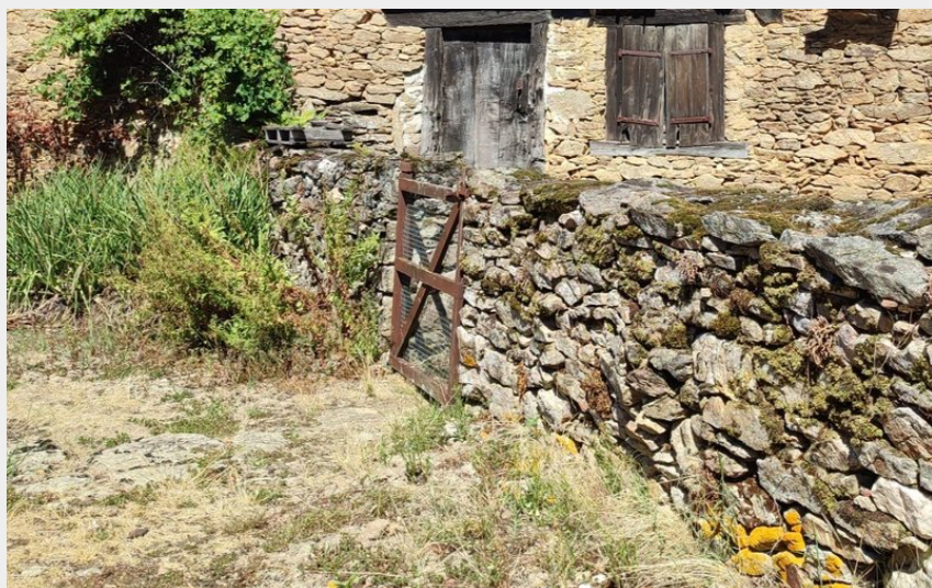
Bâti rural à Buffengeas (A. CLAVREUL - PETR du Pays Monts et Barrages)
